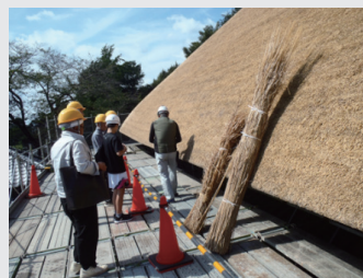
民家屋根葺き工事見学
