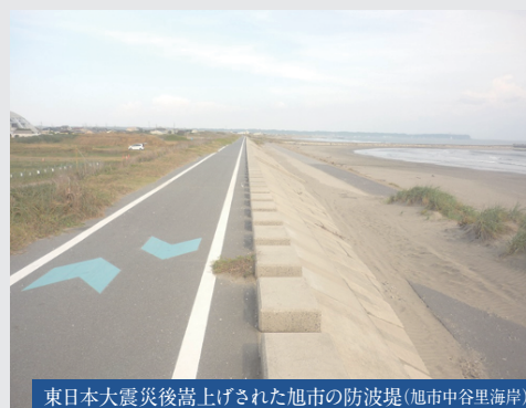
東日本大震災後嵩上げされた旭市の防波堤(旭市中谷里海岸)
