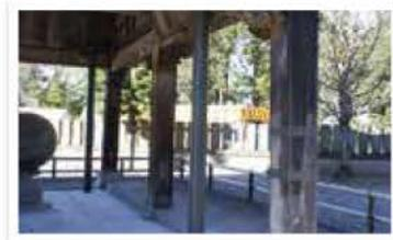
倒壊の危険が有りました。そこで四隅の柱に鉄パイプで補強をして以前の根接ぎ部分には、金属板にてベルト状に補強をしました。
