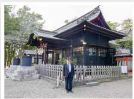
◀平成29年修復工事完成 (本殿は(株)金剛組によるもの) 外部は黒のカシュー塗り (本殿以外は(株)さわの道玄)
