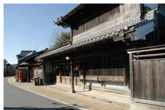
現在は住宅になっている旧商家の町並
