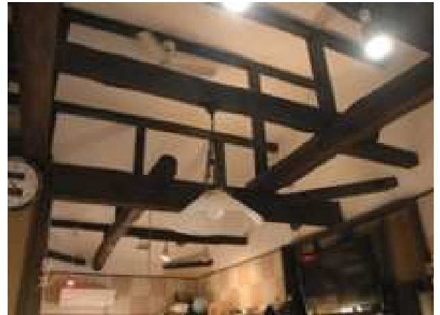
事務局の一部に古民家の古材を再利用した小屋組があり、展示スペースとしても利用しているとのこと。
